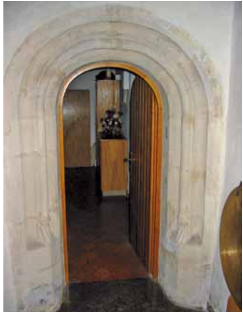
Romanische Pforte zur Sakristei
